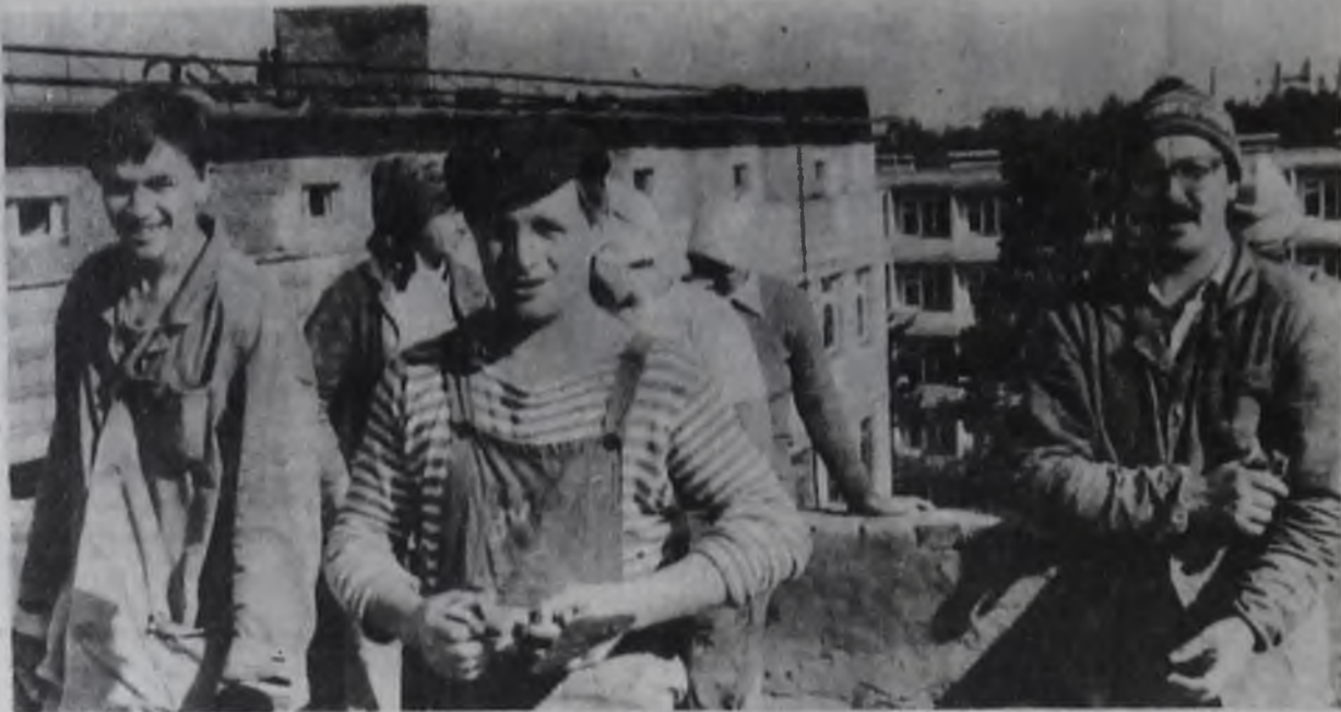
Недавно сюда пришли штукатуры из бригады Г. Ощепковой из СМУ-5.
