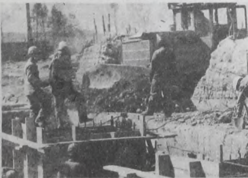
Фундамент лесопильного цеха возводит бригада СМУ-2 А. Д. Демещука.
