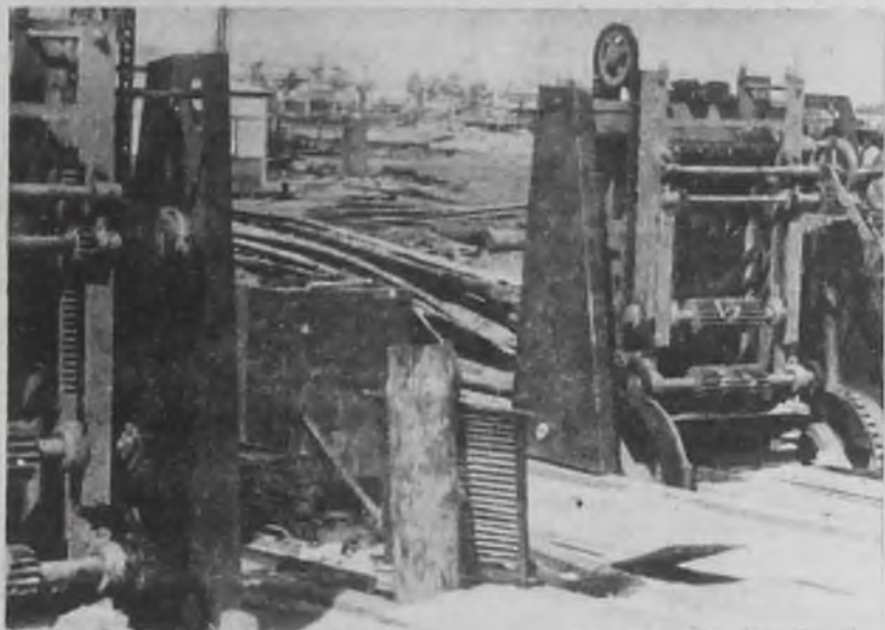
Монтаж пилорама на Зверевском участке ДОКа.
