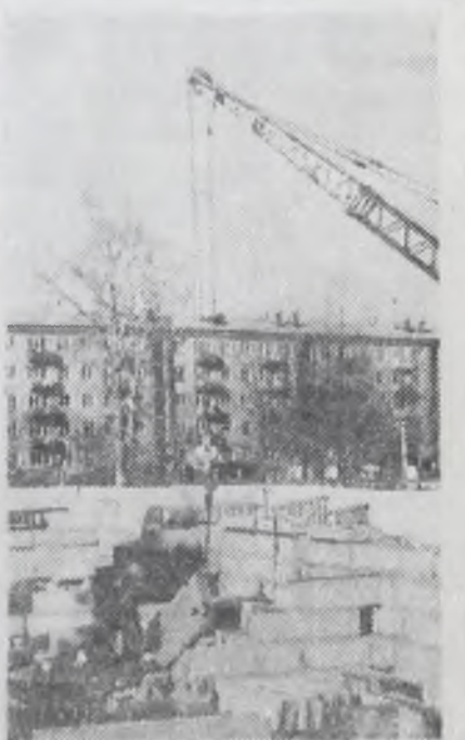
Строится дом 23 тринадцатого микрорайона. Фото А. МАКЕКО.
