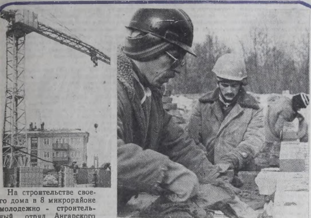
На строительстве своего дома в 8 микрорайоне молодежно - строительный отряд Ангарского управления строительства закончил кладку второго этажа и приступил к возведению следующего, третьего этажа. Стоит отметить, что дом строится полностью из кирпича, и потому нужно немало усилий выдерживать взятый большой темп ра-
