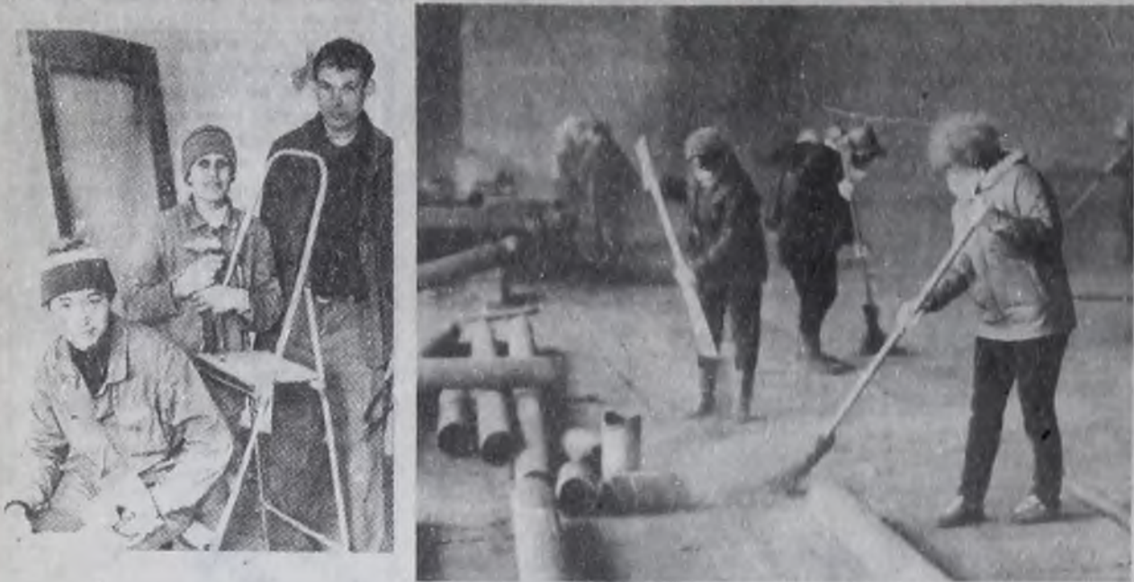
Электромонтажники МСУ-76 Н. Степанов, Р. Ф. Лыпкань, Ю. Вислых в день субботника продолжали монтаж электропроводки и другого оборудования на одном из блоков строящегося роддома. Вместе с ними работали и остальные члены бригады МСУ — всего 8 человек под руководством бригадира А. Н. Белинского. Работники бухгалтерии АУС на уборке одного из будущих цехов корпуса крупноблочных устройств Ангарского электро-механического завода. Фото А. КОКОУРОВА.
