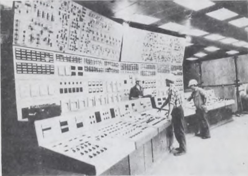
ХАБАРОВСКИЙ КРАЙ. Мощная ТЭЦ с замкнутым водооборотным циклом вступила в строй в Комсомольске-на-Амуре. Она экологически безвредна, так как вместо каменного угля использует природный газ. На снимке: блочный щит управления ТЭЦ-3. Фото В. Тарабушка. ТАСС.
