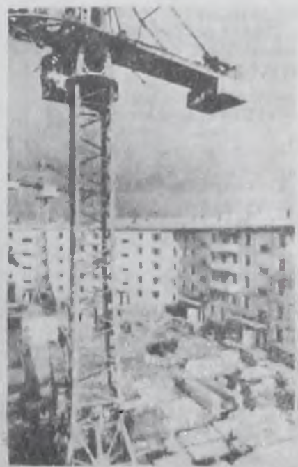
На стройплощадке 17 микрорайона.
