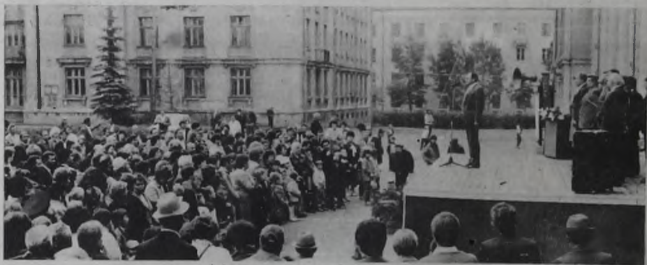
Митинг строителей на площади им. В. И. Ленина.
