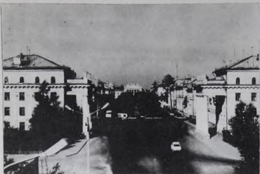
Въезд в город со стороны железнодорожного вокзала. Фото А. ПОПОВА.
