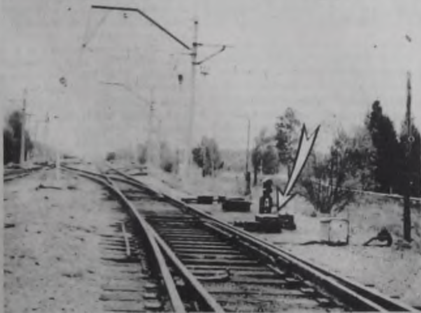
Автоматический привод для дистанционного управления стрелочным переводом.
