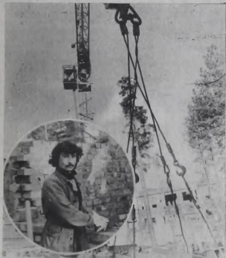
В день субботника на строительстве профилактория АУС. Андрей Комин из бригады А. Коркина работает на кирпичной кладке стен будущего бассейна.
