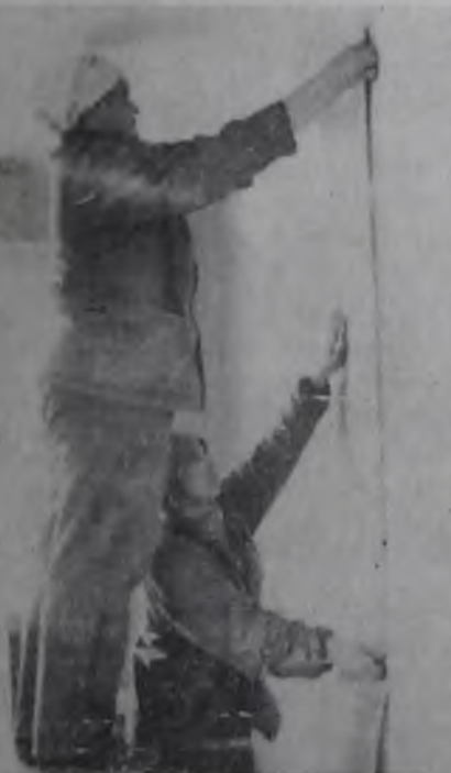
Последние метры обоев наклеивают в жилых комнатах общежития.
