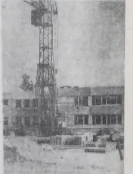
На строительстве детского сада в 17 микрорайона.
