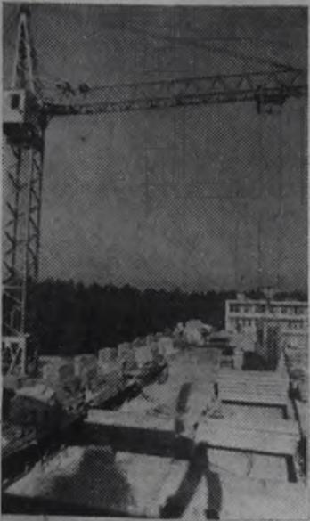
На строительстве профилактория для объединения «Ангарскнефтеоргсинтез» работает бригада 4-го участка СМУ-9 Н. А. Касьянова. Три блока — грязе- и водолечебниц, поликлиника — будут соединены в одно здание. На водолечебнице пока еще нет потолочного перекрытия, на грязелечебнице близится к завершению нулевой цикл.
