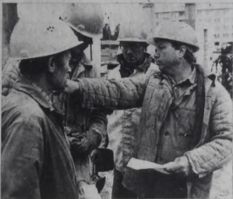
Бригада СМУ-1 Александра Николаевича Голубородова, работающая на строительстве детского учреждения № 13 в 17 микрорайоне, план августа выполнила. Освоено 67 тысяч
