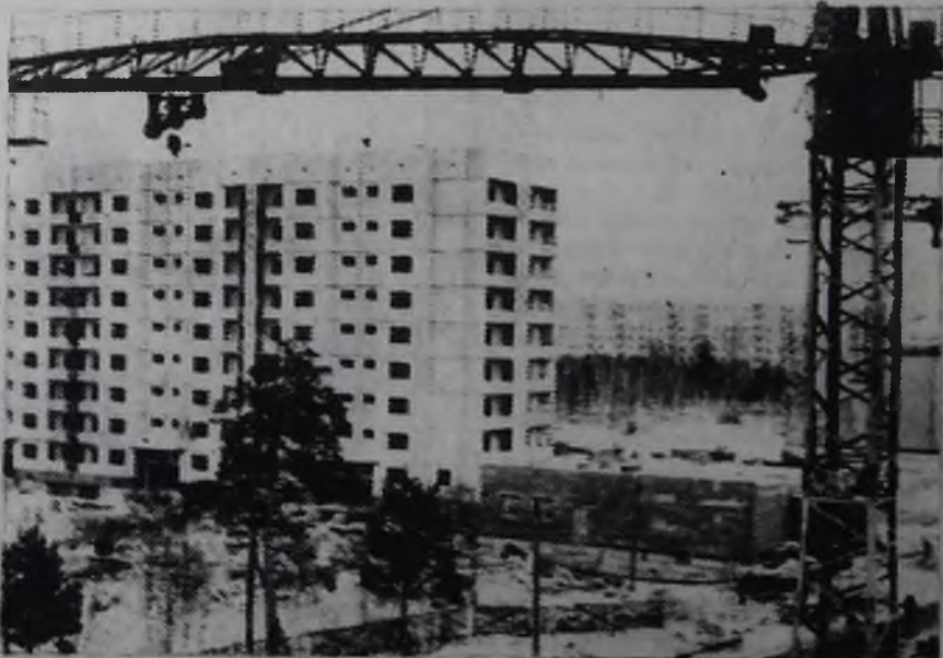
Строятся дома в 12а микрорайоне.
