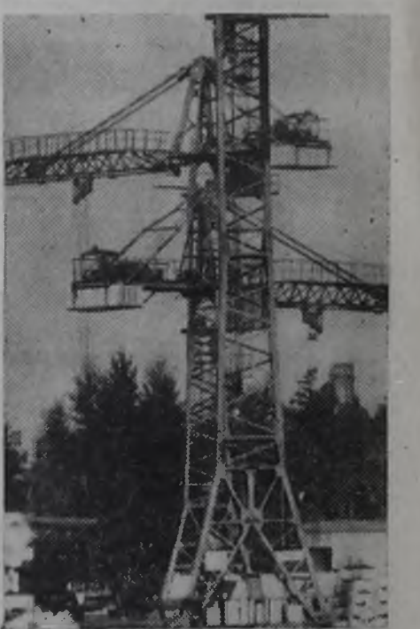
На полигоне ЗЖБИ-5.
