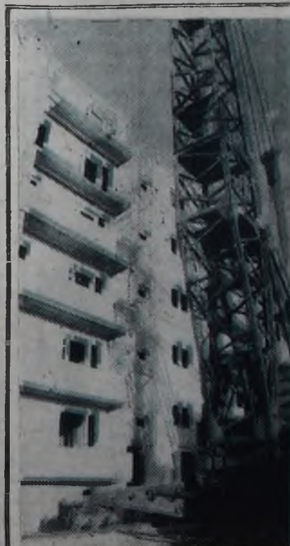
Строится дом в 17 микрорайоне.
