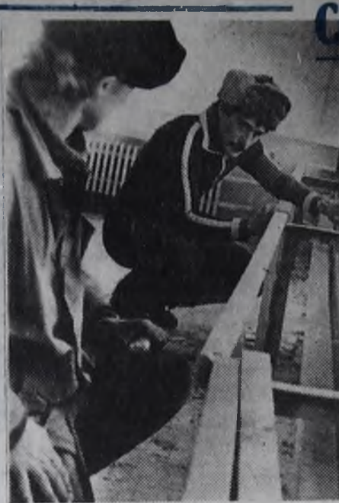
Отделочные работы на магазине «Универсам» в 18 микрорайоне, что называется, вступили в завершающую стадию. В будущих торговых залах уже выложена плитка, окрашены панели, переплеты окон, ведется обделка деревом радиаторов отопления. В этом месяце строители должны сдать этот объект социального назначения.
