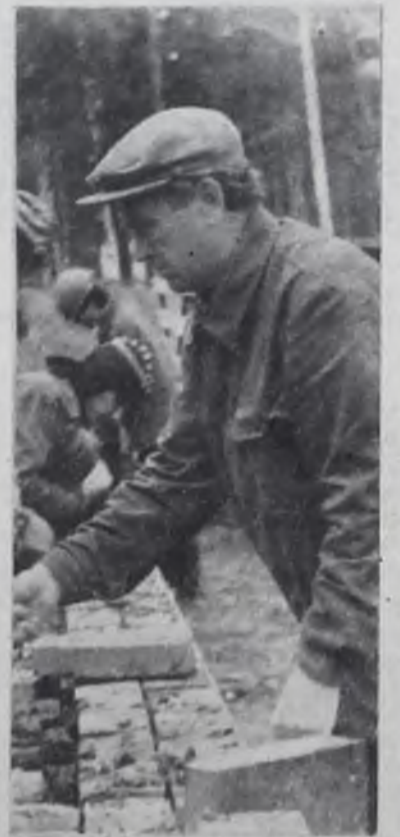
На снимке: ребята самостоятельно выкладывают кирпичную стену; А. Д. Бадгауэр — инструктор межшкольного комбината.
