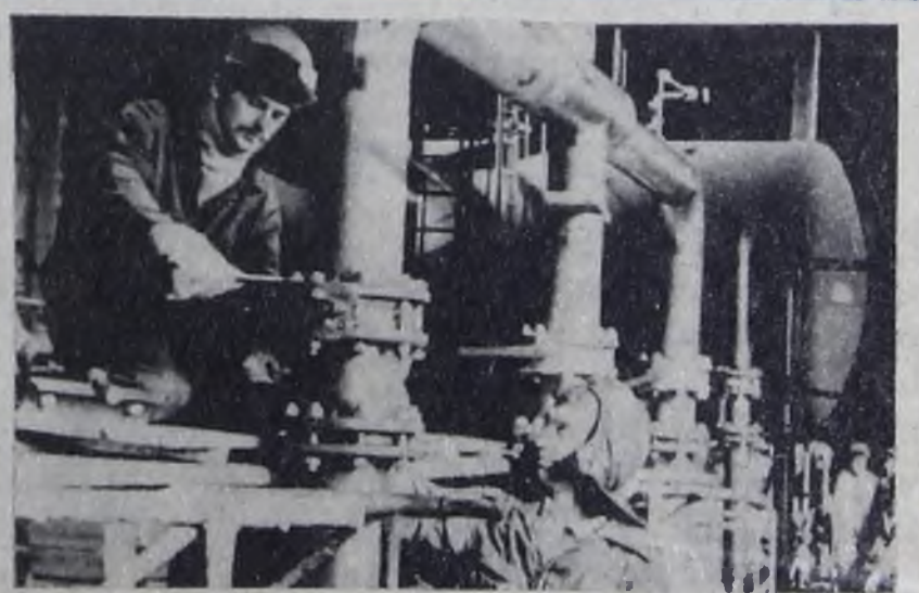
Энергоблок: на монтаже оборудования. Фото А. МАКЕКО.
