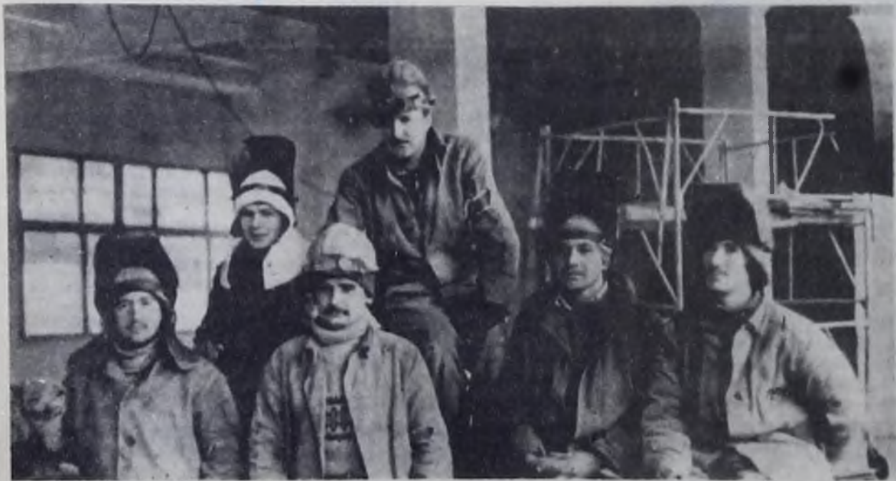
Хорошо работают на монтаже оборудования представители МСУ-42, в частности, бригада В. М. Алексеевича.
