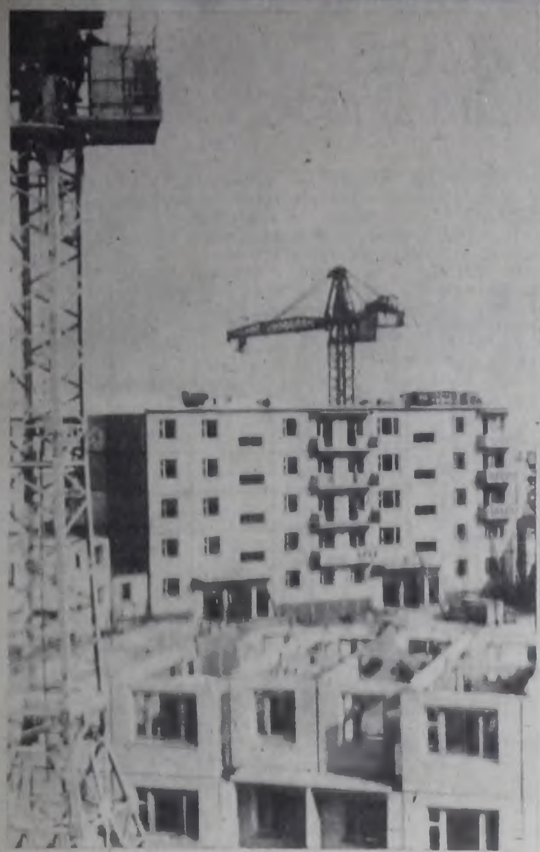
На стройплощадке 17 микрорайона.
