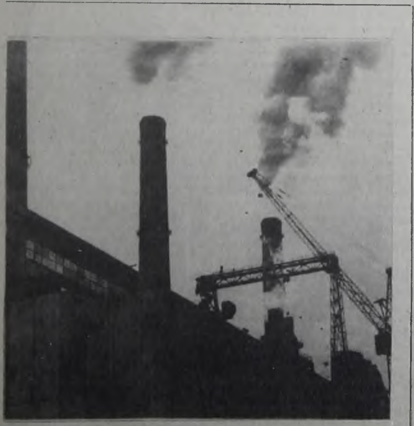
Третья очередь ТЭЦ-9, строительство продолжается.
