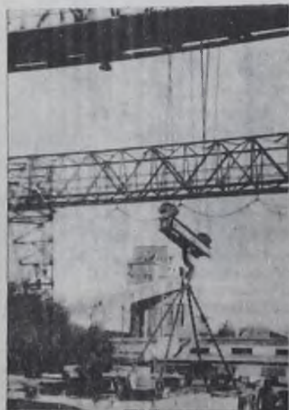
На снимках полигон завода железобетонных изделий № 2; одна из лучших арматурщиц,
