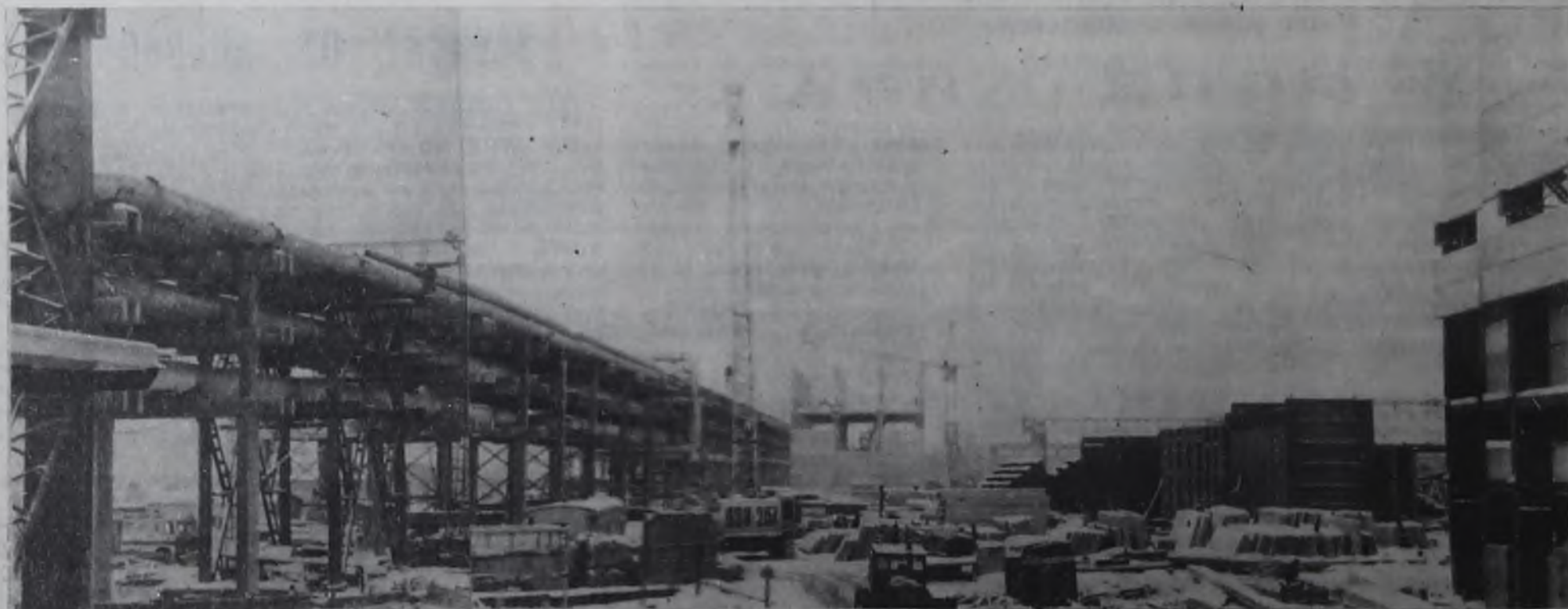
На снимке: фотопанорама строительной площадки комплекса ТЭЦ-9;
