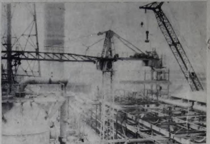
На снимке: идет монтаж технологического оборудования на комплексе аммиака.
