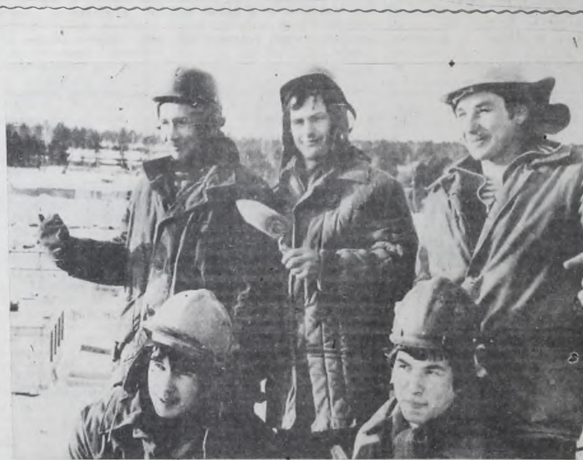
Борются за звание ударников коммунистического труда молодые рабочие из бригады Э. А. Гейна (СМУ-1). Ребята на стройке не так давно, но работают со старанием, осваивая специальность, участвуя в общественной работе. Словом, берут пример со своего наставника-бригадира. На снимке: каменщики бригады Э. А. Гейна — комсомольцы В. Лушников, П. Михайлов, А. Казакевич — комсорг бригады, А. Синьков, А. Фарков.
