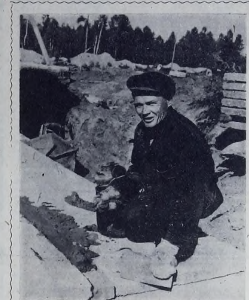
Уже более 25 лет трудится на стройке Николай Николаевич Кузнецов — трубоукладчик из комплексной бригады В. М. Самозванцева — первого строительного-монтажного управления, Н. Н. Кузнецов имеет почетное звание ударника коммунистического труда.
