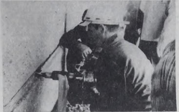
тор применяется в комплекте с преобразователем частоты тока ИЭ-9401 с выходной мощностью 4 квт.
