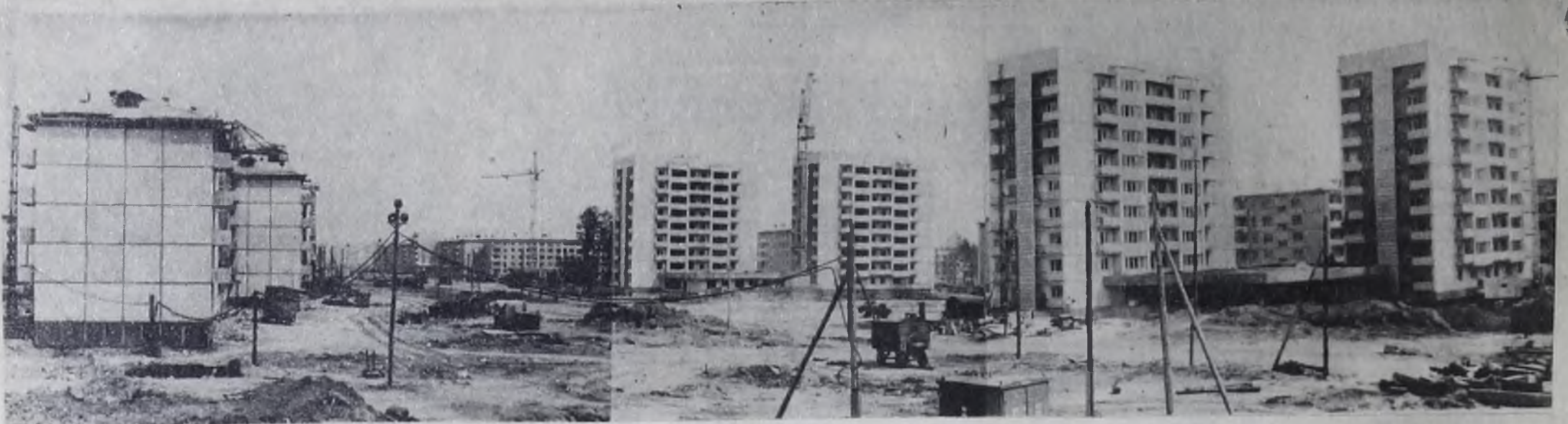
ПАНОРАМА СТРОИТЕЛЬСТВА ЖИЛЬЯ В 22 И 15А МИКРОРАЙОНАХ.
