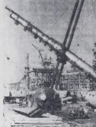
**НА КОМПЛЕКСЕ** аммиака идет напряженная работа. В субботу, 21 марта, здесь был произведен уникальный подъем очередной технологической колонны «Абсорбер 101 ЕВ», весом 250 тонн и высотой 58,4 метра.
