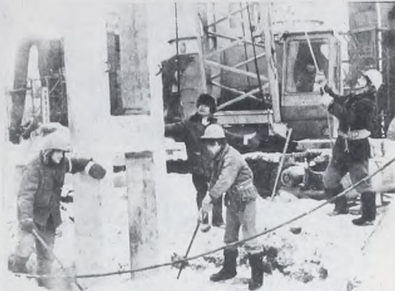
Комплексная бригада В. Васильева из СМУ-6 трудилась на строительстве завода БВК.
