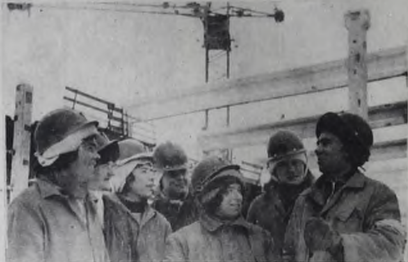
Бригадир Николай Антонович Касьянов из СМУ-11. Бригада Н. А. Касьянова на строительстве холодильника.
