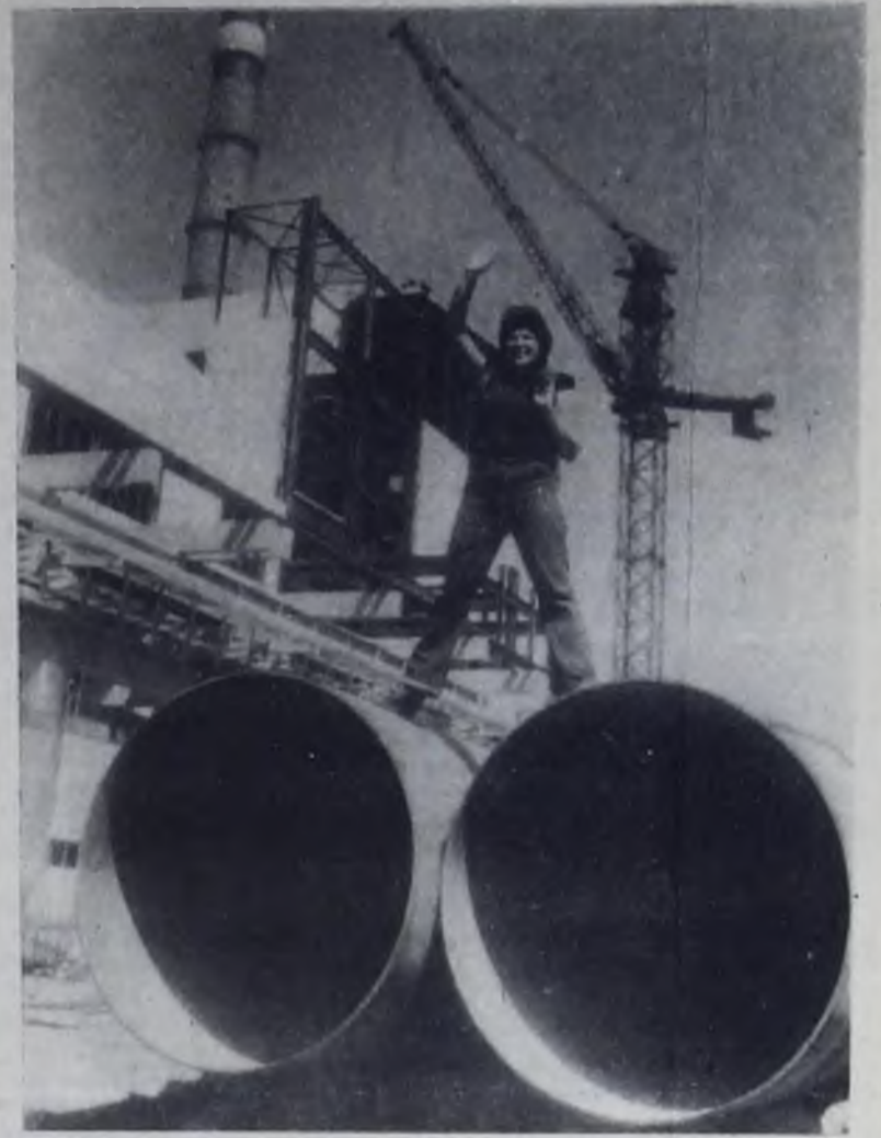
Строится Ново-Зиминская ТЭЦ.
