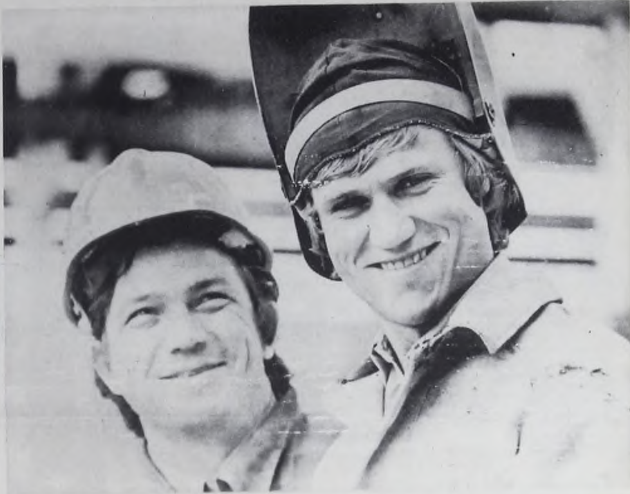
На строительстве второй очереди АЭМЗ трудится монтажник Михаил Сойников и комсомолец электросварщик Сергей Бабенко.
