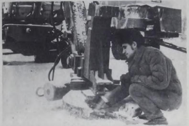
Определенным препятствием на пути комплексной механизации свайных работ являются трудности технологического характера. По существующей технологии строительства свайного основания все работы по резке головок выполняются, как правило, после забивки всех свай. Это вызвано принятой последовательностью выполнения связанных между собой процессов, условиями безопасности работ и требованиями СНиП на добивку пробных свай после их «отдыха».
