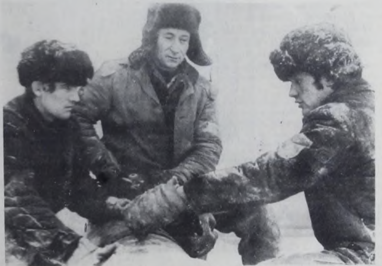
● ЭП-300. На комплексе ЭП-300 ударно трудится бригада тов. Евдокимова из Усольского монтажного управления. По объекту 1928 они ведут монтаж технологических трубопроводов и оборудования. С хорошими показателями закончила эта бригада юбилейный год.
