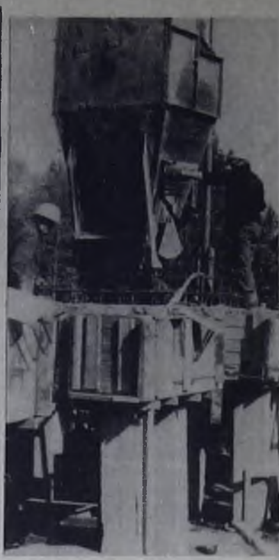
▲ В 19 микрорайоне бригада монтажников из СМУ-1 С. А. Добрынина начала строительство дома № 3г. Это уже девятый дом микрорайона. На снимке В. Небогина — бетонирование фундамента.
