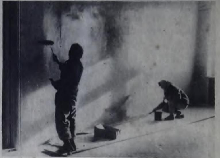
Звено № 4 — 3 чел. (2 чел. — 3 раз., 1 чел. — 2 раз.) оштукатуривает потолки, резка рустов вручную.
