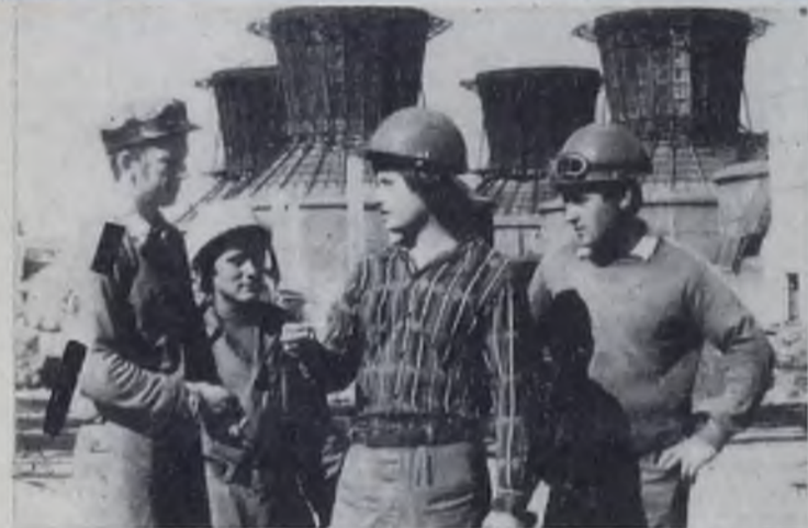
Свидетели вдохновенного труда, четкие контуры градирен — объекты 1654 и 1654а — горделиво возвышаются за спинами монтажников Ю. И. Овчинникова, В. И. Башкирцева, Ю. Б. Карапуха, Н. В. Лещенко из бригады заслуженного строителя РСФСР В. Л. Лещенко из СМУ-42. Методом бригадного хозрасчета, но уже комплексного, бригада В. Л. Лещенко трудится сейчас на градирнях площадки комплекса ЭП-300.
