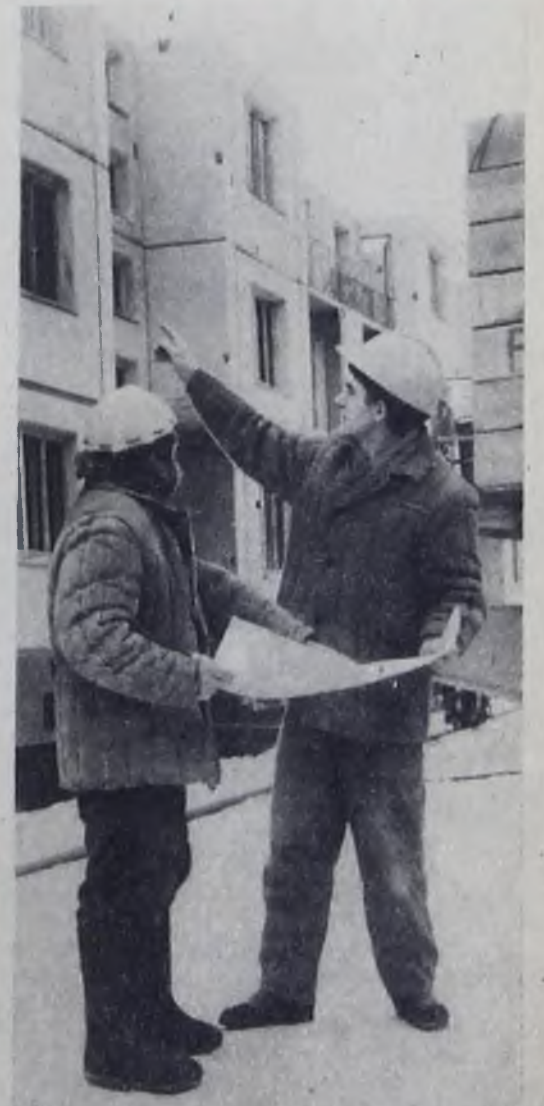
На снимке вы видите бригадира СМУ-1 Михаила Ивановича Старикова, чей коллектив сегодня закончил строительство девятиэтажного дома первой серии по ул. Чайковского.
