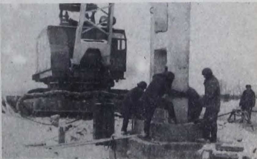
Второй год пошел комплексной бригаде монтажников на СМУ-1, которую возглавляет Михаил Зарипов. В основном она занимается монтажом и сваркой сборного железобетона. В первом году десятой пятилетки коллектив трудился на строительстве второй очереди электромеханического завода. С планом справился досрочно. В настоящее время монтажники продолжают строительство бытового корпуса завода. Уже готовы четыре этажа. 140-150 процентов — таковы ежедневные показатели бригады.
