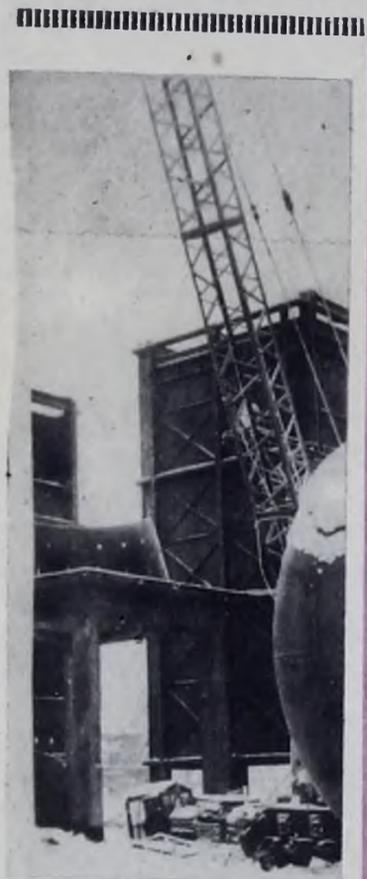
На снимке: один из участков строительной площадки реформинга. Из пяти печей осталось смонтировать две. Монтажные готовят фронт работ: перебазируют башенный край и принимают первые партии огнеупорных блоков.
