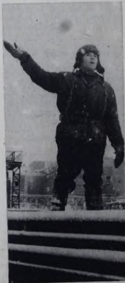
А. А. Горбачев — передовой монтажник МСУ-42, коммунист. Его бригада завершает работы на комплексе этилбензола.
