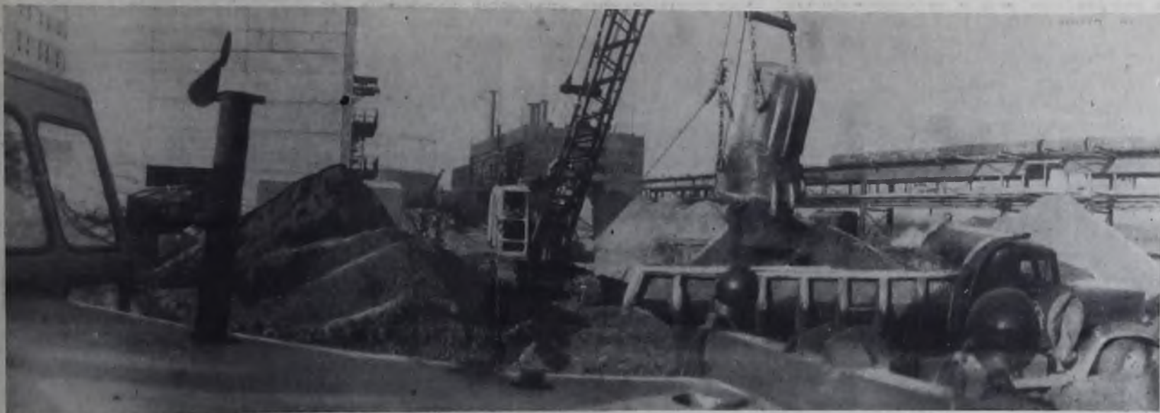
Большой объем работ выполняет на шуковых комплексах и объектах жилья и культурно-бытового назначения коллектив СМУ-7. Он первым готовит котлованы под здания, последним завершает устройство дорог, заборов, посадку ку-
