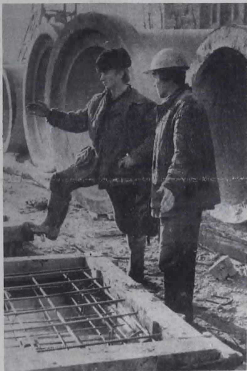
Бригада формовщиков В. Н. Надеина на заводе ЖБИ-3 среди других заказов выполняет важнейший по поставке железобетонных труб большого диаметра для треста Зимахимстрой. Установленное задание на октябрь она перевыполнила на 150 кубических метров. Успешно справляется коллектив и с выпуском другой продукции.
