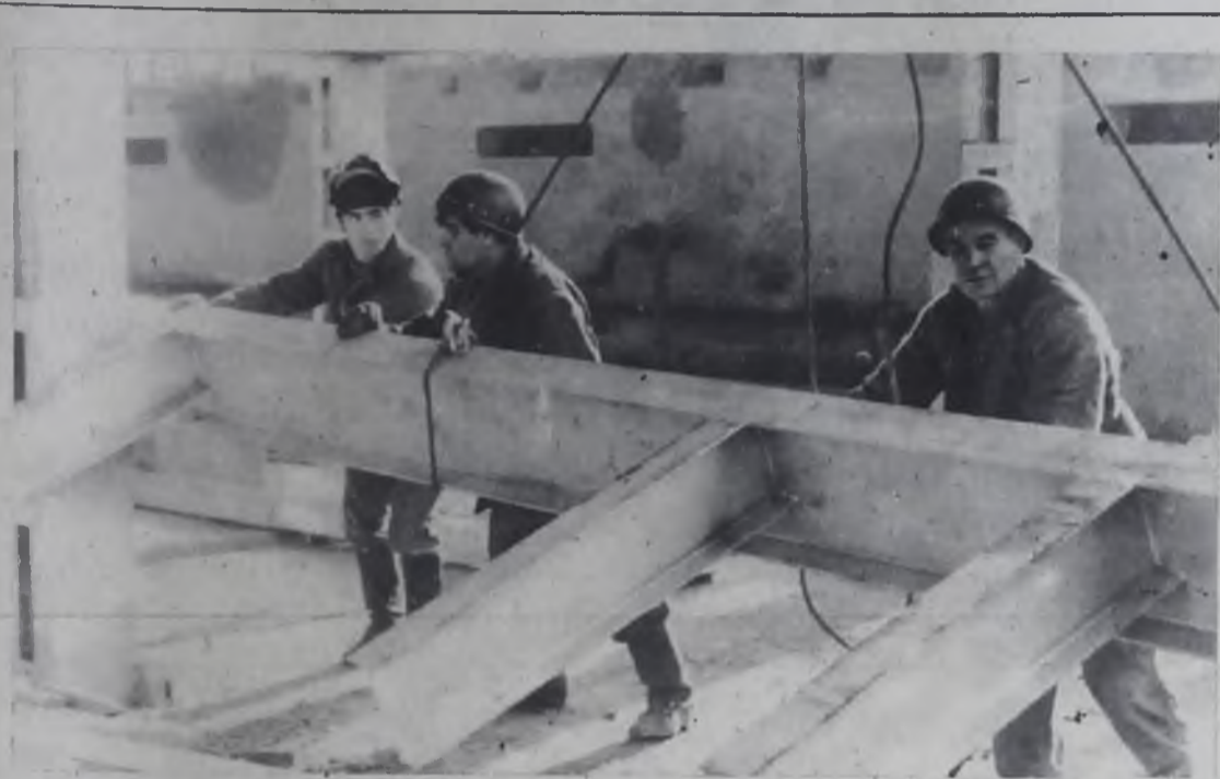
Бригада монтажников МСУ-42, которую возглавляет заслуженный строитель РСФСР Иван Федорович Ларькин, сегодня трудится на пусковом комплексе полиэтилена. Она в кратчайший срок завершила монтаж металлоконструкций на объекте 10-74 и в настоящее время готовится к работам по компрессорам.
