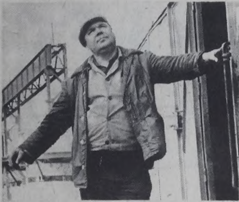
Алексей Семенович Павлов работает машинистом крана в управлении механизации и автомобильного транспорта треста Востокхиммонтаж. Передовой рабочий всегда выполняет задания на монтаже объектов нефтехимии.
