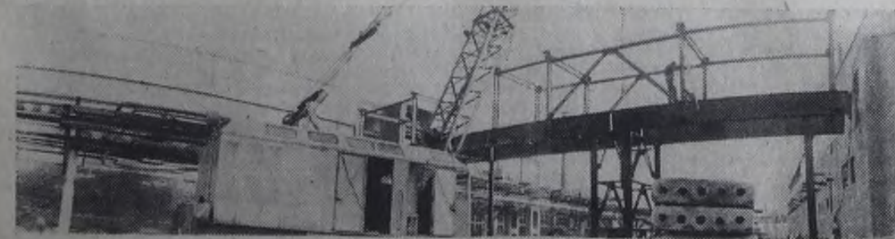
Строится комплекс полиэтилена. Фото В. НЕБОГИНА.
